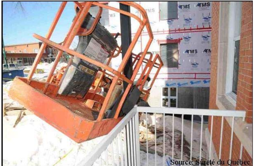
Photo 8: Nacelle appuyée sur le balcon
