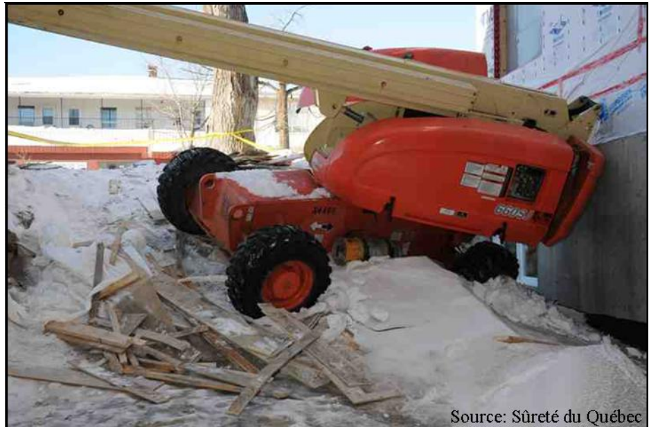
Photo 3: Lieu de l'accident vu à partir du bas du talus
