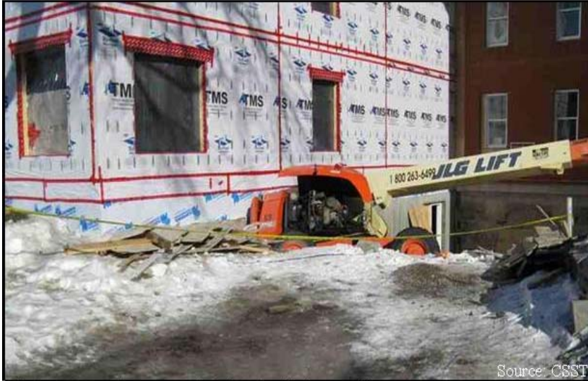
Photo 6: Emplacement du châssis de la nacelle
