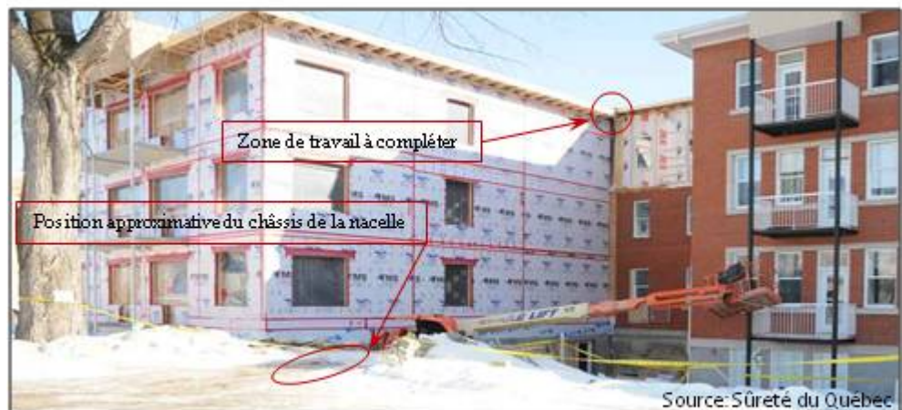
Photo 5: Localisation de la zone de travail à compléter
